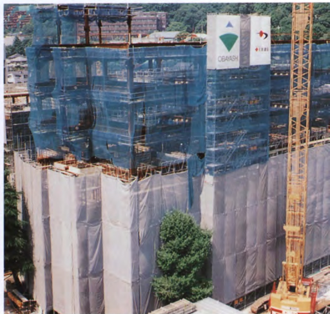
平成8年8月31日 1・3号館工事進捗状況
