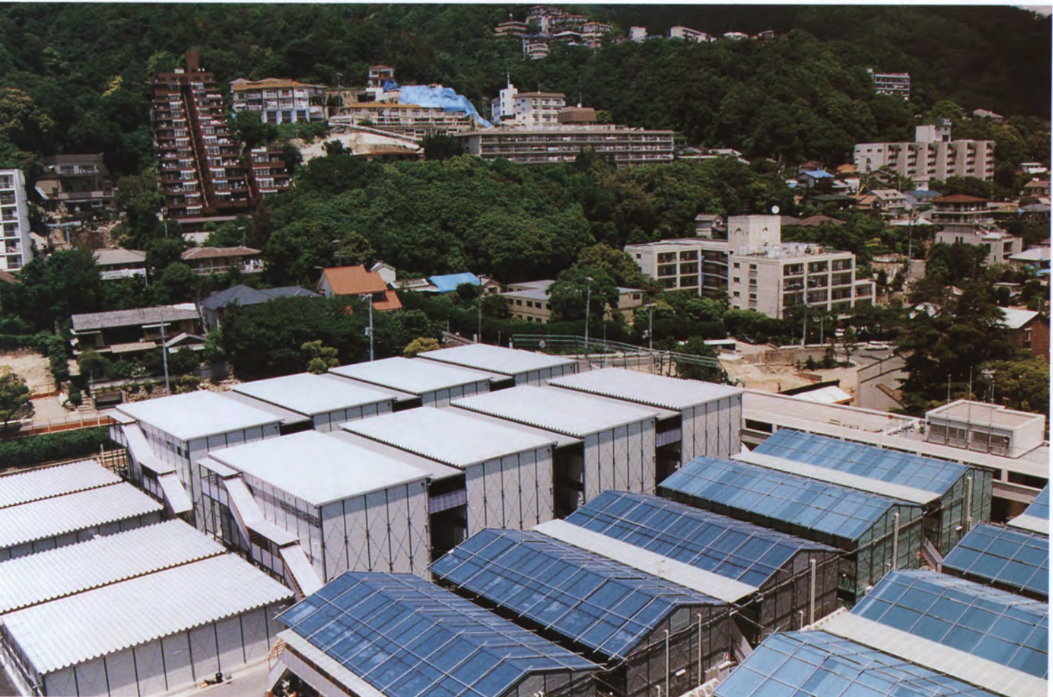
完成した仮設校舎
