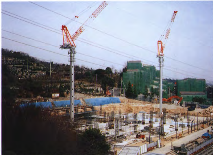
平成8年3月28日 工事進捗状況
