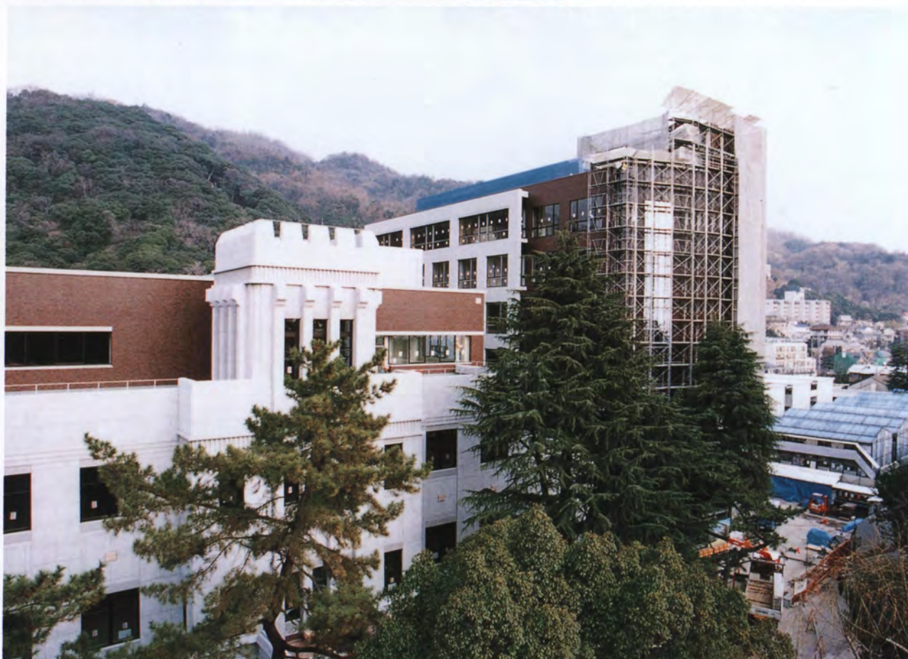
平成9年1月27日 竣工間近の1・3号館
