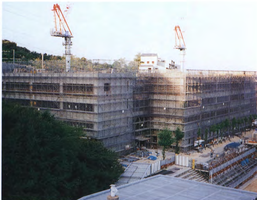
平成8年8月31日 工事進捗状況
