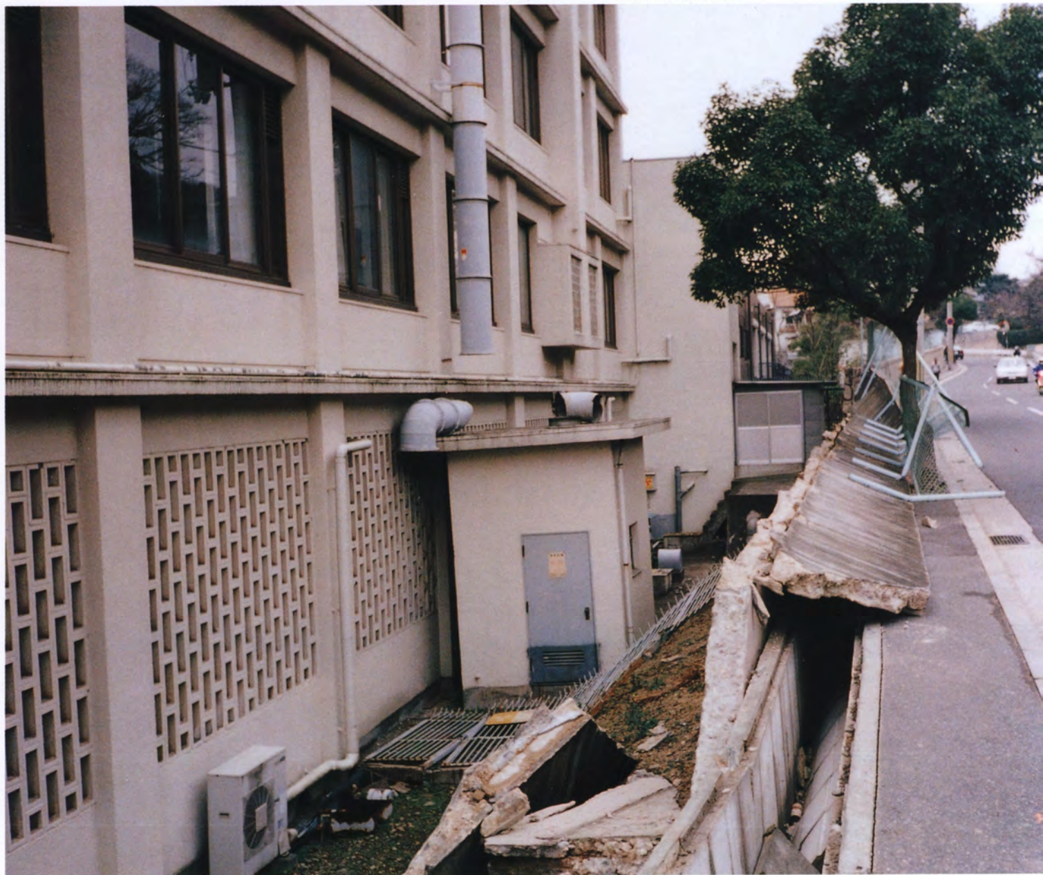
11号館北側の塀
