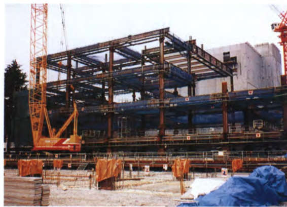
平成8年3月6日 基礎工事
