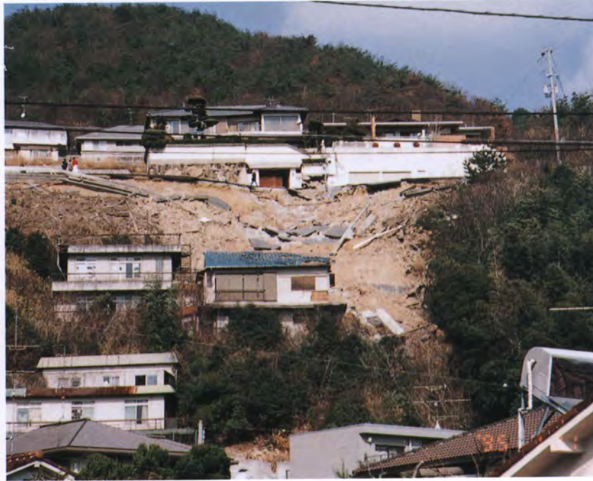
西岡本の土砂崩れ
