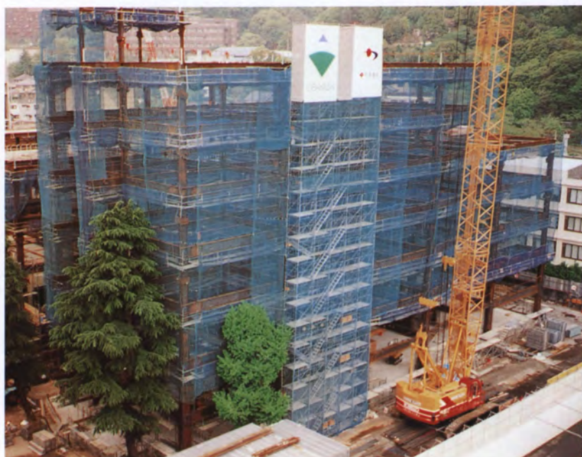
平成8年4月30日 1・3号館工事進捗状況
