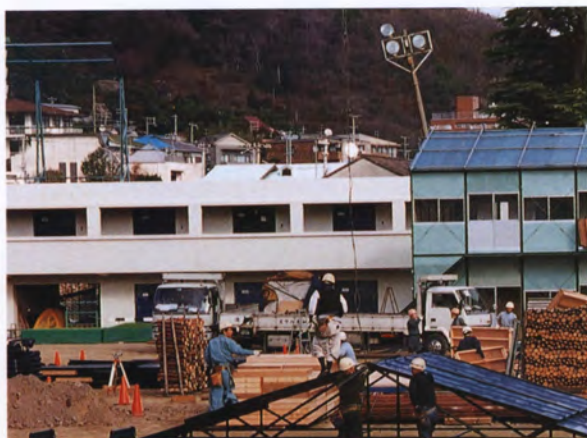
建設中の仮設校舎
