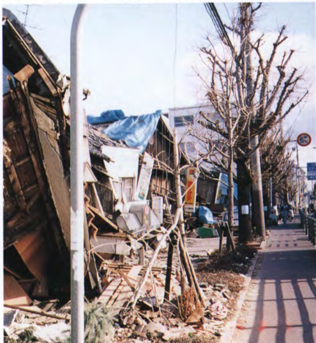
国道2号線沿い芦屋付近
