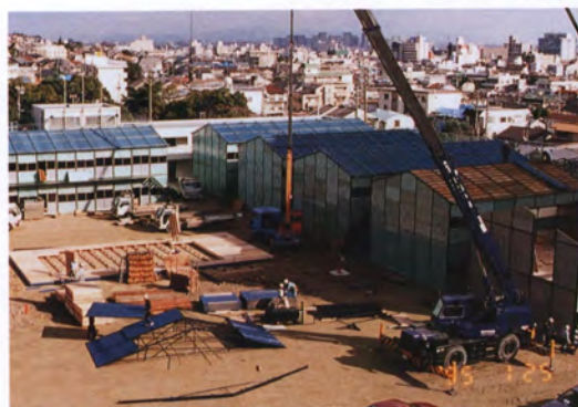
建設中の仮設校舎
