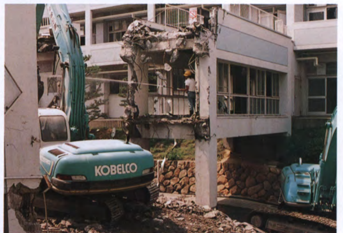
3号館渡り廊下
