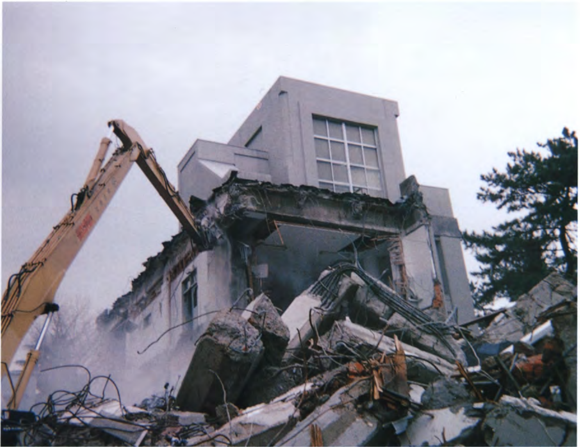
取り壊される1号館
