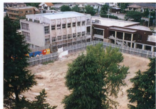
取り壊された1・2・3・5号館の跡地
