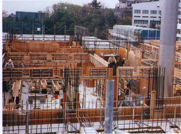
平成8年4月6日 工事進捗状況
