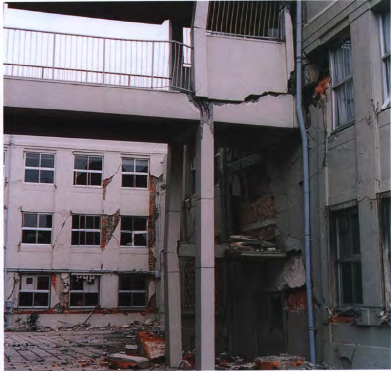
西側から見た1号館北側
