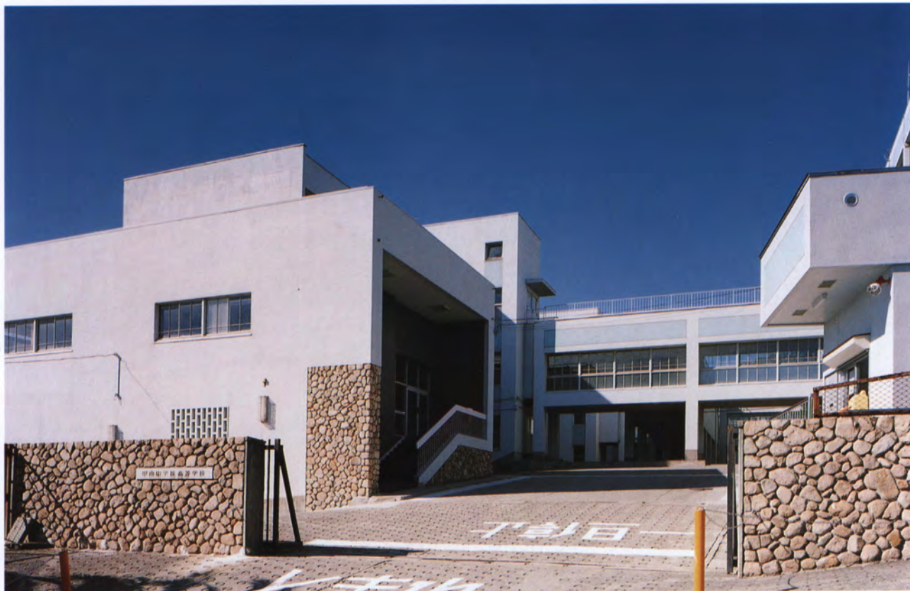
正門から見た1号館（左側）
