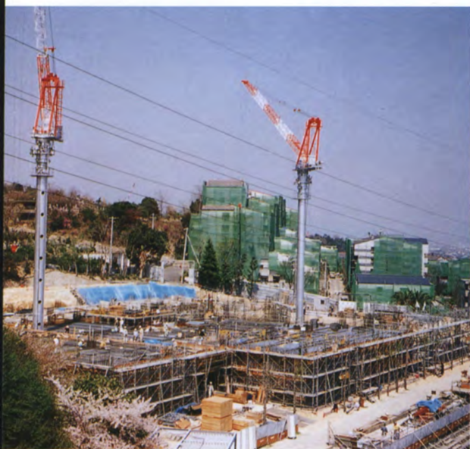
平成8年4月24日 工事進捗状況
