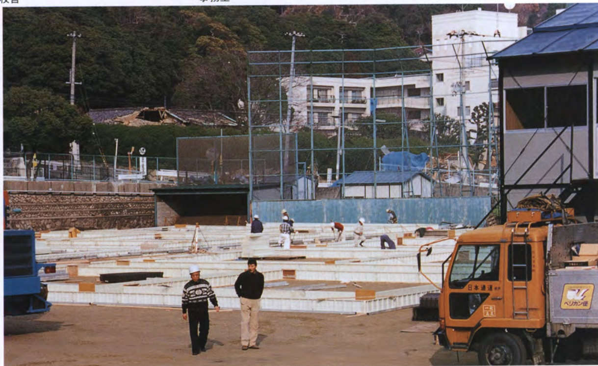
建設中の仮設校舎
