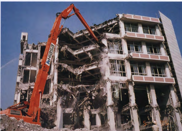
取り壊される2号館
