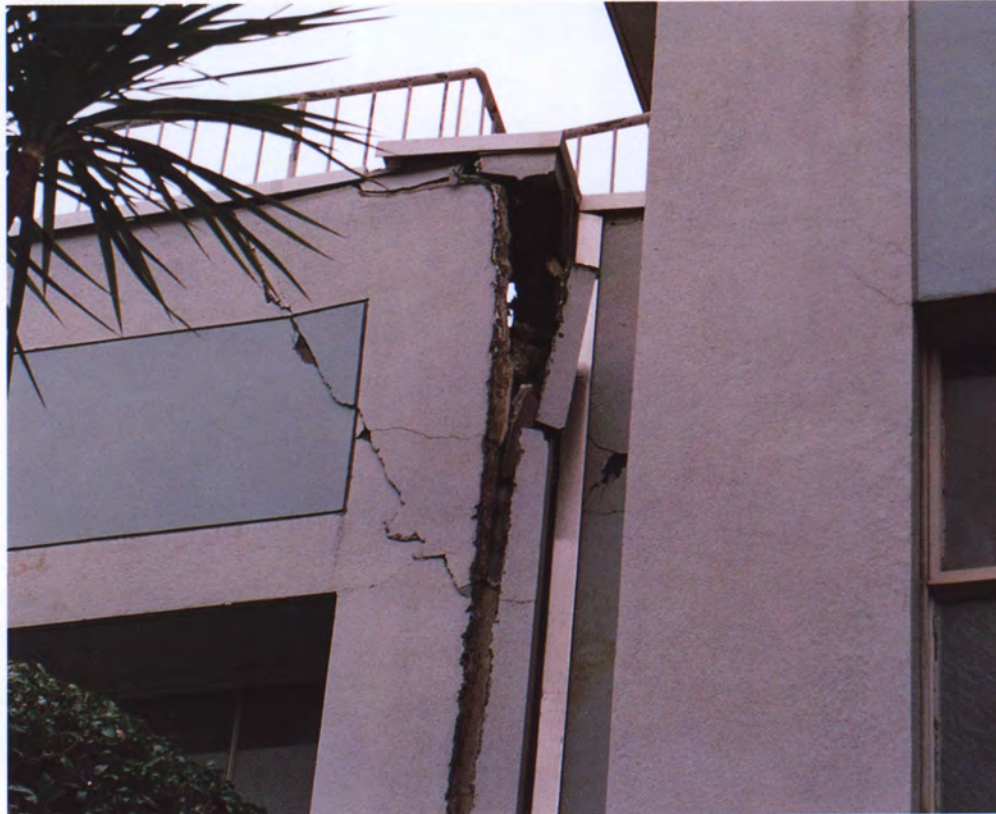
1号館（右）と3号館の渡り廊下
