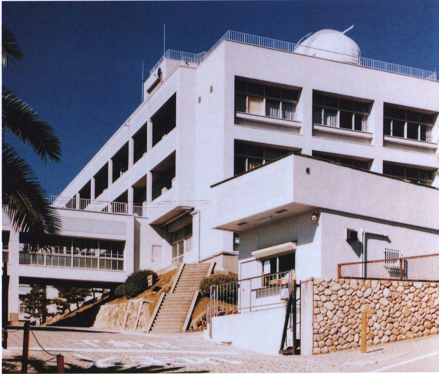
正門から見た2号館
