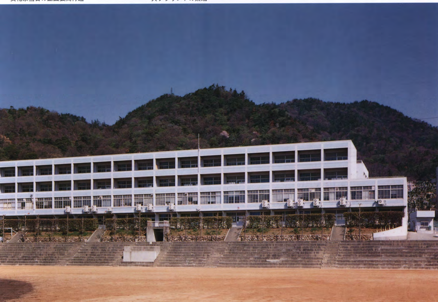
大グラウンドから見た1号館
