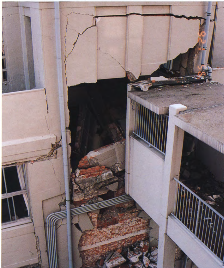
2号館から見た渡り廊下
